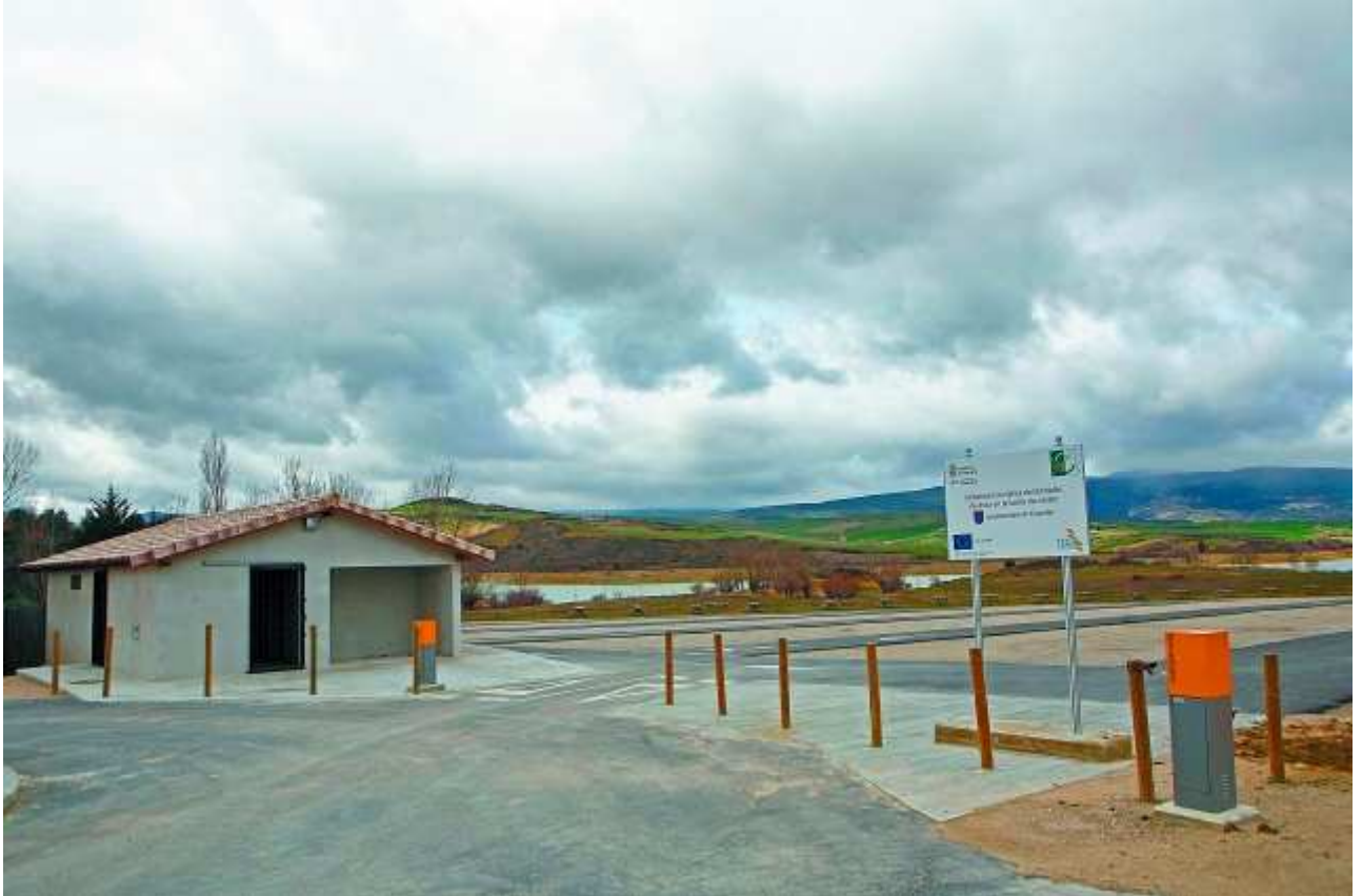
Nuevas infraestructuras ya terminadas en la bahía de Lerate, que se inaugurará en breve. MONTXO A.G.
